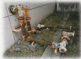
配管の腐食
